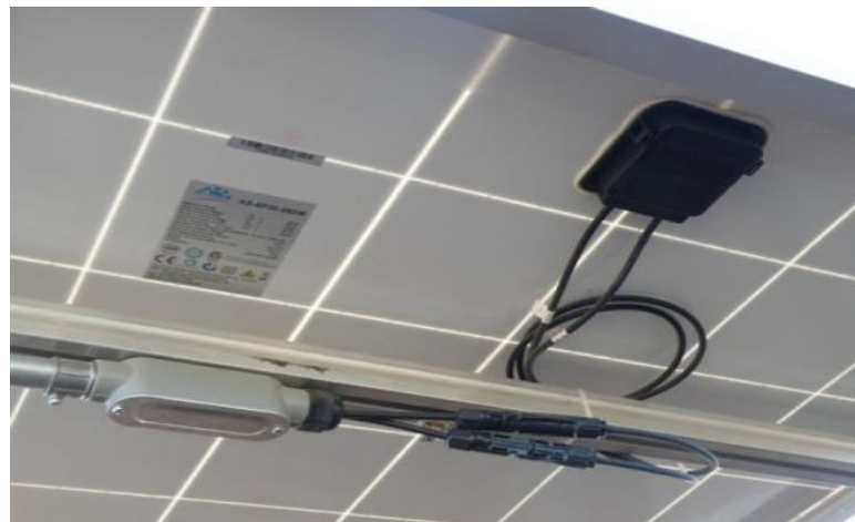
Panel Solar de 260W, conectado a un banco de baterías con una carga total de 800W por cada día de autonomía.
